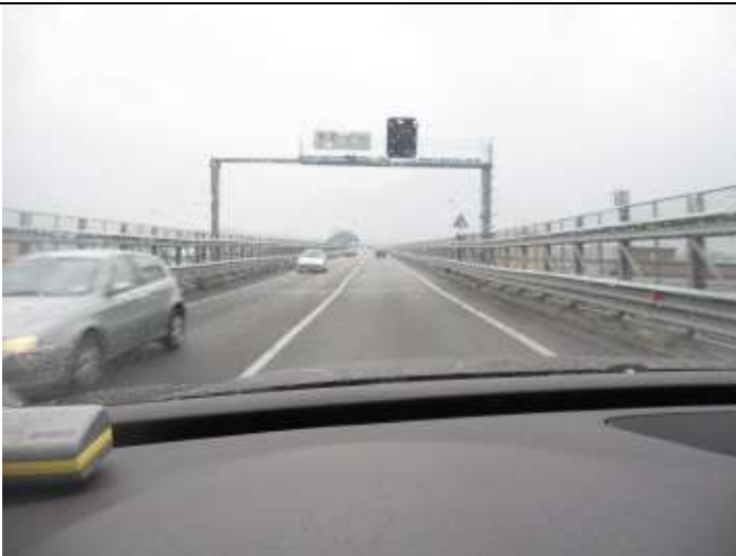
Sopraelevata per Sorrento – Raising street to Sorrento
