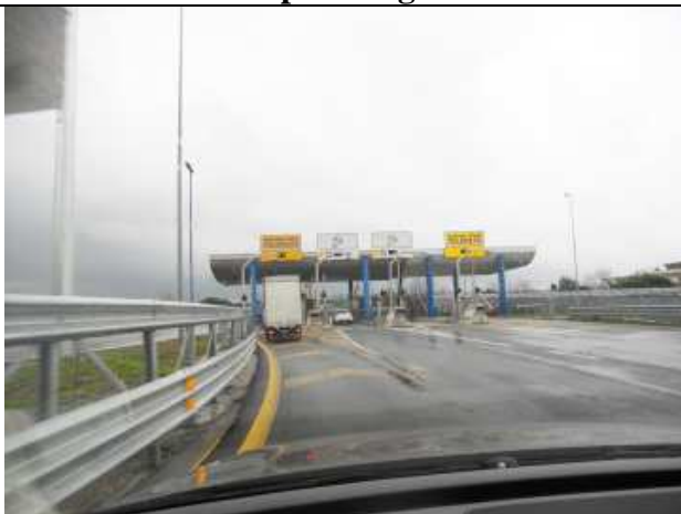
Casello ingresso Napoli Salerno A3 – Tollgate Napoli Salerno A3 highway
